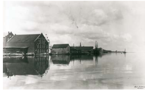
Mikkelsens Møbelfabrikk sett fra Gandsfjorden.
