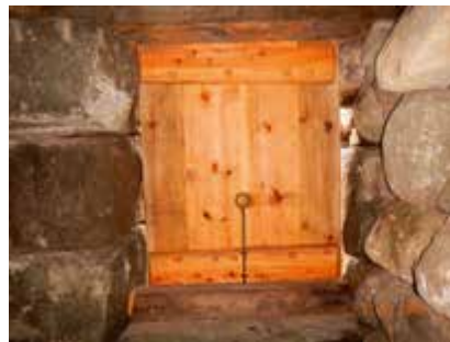
Luka til innlasting av jern er på plass i smia.
