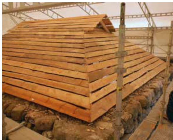
Taktro er ferdig.
