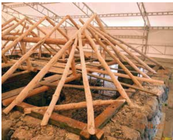
Sperr er ferdig. Klart for taktro.
