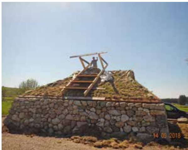
I mai 2018 var pipa på essa komen gjennom taket og muringa føregjekk ute.
