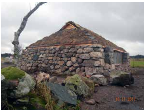
16. november 2017 er telt og stillas demontert. Tak og mur er ferdig.
