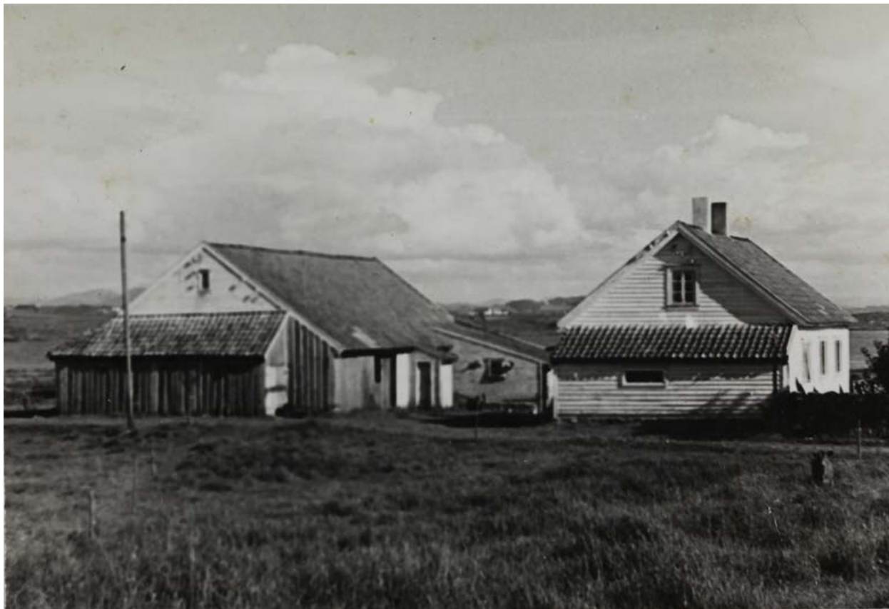
Utedoa på gardsbruket vart bygde inni eller inntil løa slik som her i Vistnestunet i Randaberg. Vi ser det vesle tilbygget til fjøset, som var doet. Foto: Erling Vistnes, Jærmuseet.
