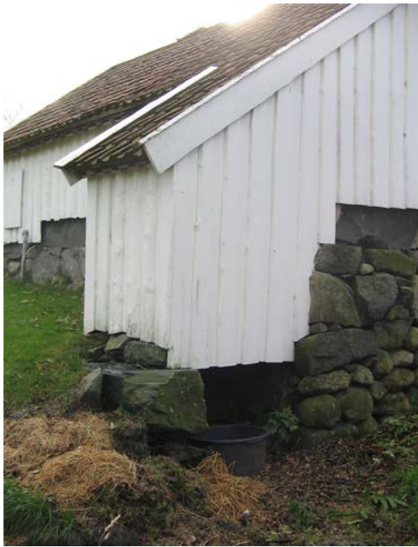
Baksida av utedoet på Kvia var heilt open. Her er det plassert ein stamp til å samla avfallet i. Då løa vart påbygd i 2015, vart denne opninga mura att. Foto: Hans Torgny Indrebø.
