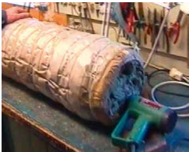
I andre enden av varmekanalen er det ein varmluftpistol som gjev den naudsynte varmen.
