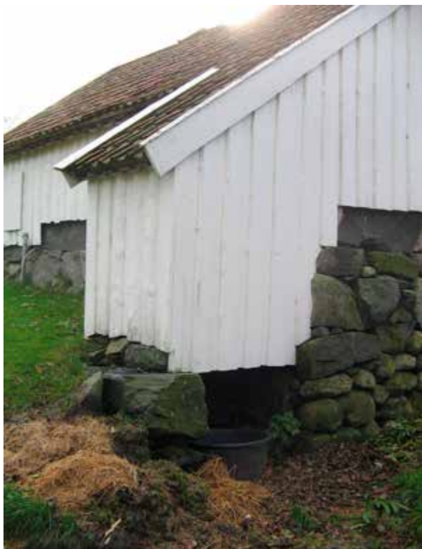
Baksida av utedoet på Kvía var heilt open. Her er det plassert ein stamp til å samla avfallet i. Då løa vart påbygd i 2015, vart denne opninga mura att. Foto: Hans Torgny Indrebø.
