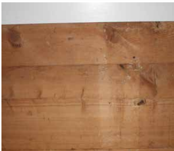
Det var laga kornbingar i stolpabuene for å halda kornet samla og for å skilja dei ulike kornslaga. Her er merke i veggjen etter skiljevegg mellom bingar. Biletet er henta frå buå til Hogne Nærland. Foto: Hans Torgny Indrebø.
