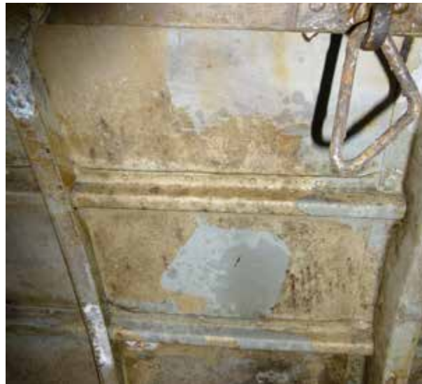
Bilde 2: original antikorrosjonsbehandling.
