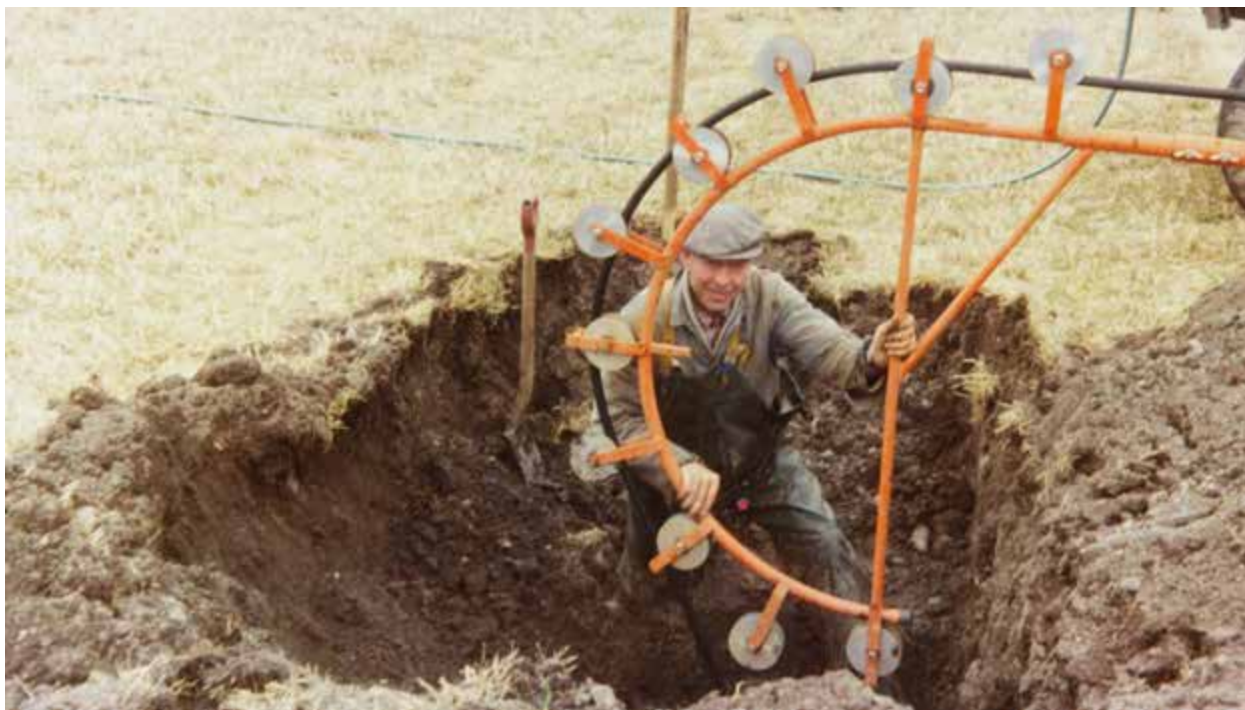
Odd Kvasdheim sjekkar at alt går rett for seg under grøftinga. Foto: Privat eige.
