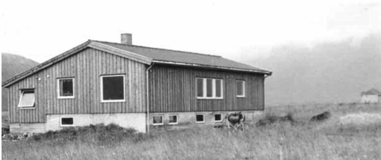
Våningshuset til Tor Kvadsheim på Hostad vart reist sommaren 1966 og er her nesten klar til innflytting.
