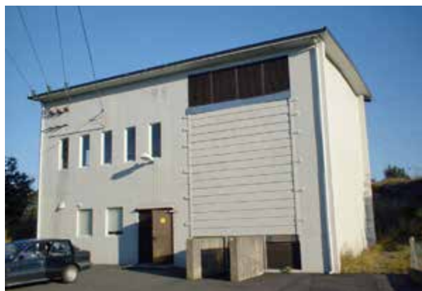
Bøe trafostasjon. Foto: Birger Høyland, Jæren Everk.
