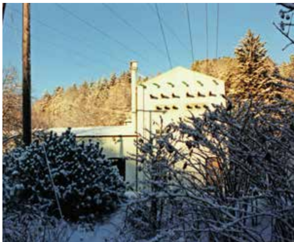
Hetland kraftstasjon en fin vinterdag i 1985. Foto: Jæren Everk.
