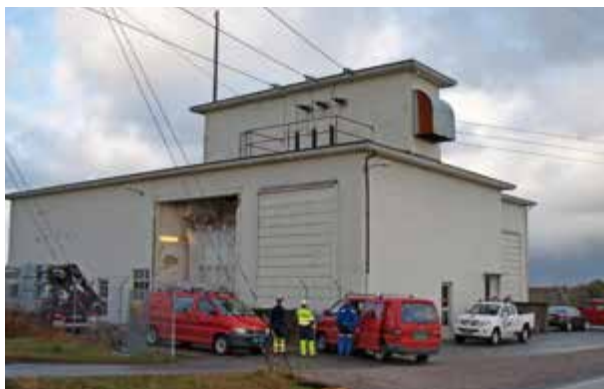
Innsetting av ny trafo på Opstad trafostasjon 4. november 2010. Foto: Birger Høyland, Jæren Everk.
