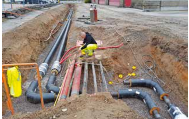
Montørene må være nøye med koblingene mellom fjernvarmerørene. Foto: Jæren Everk.
