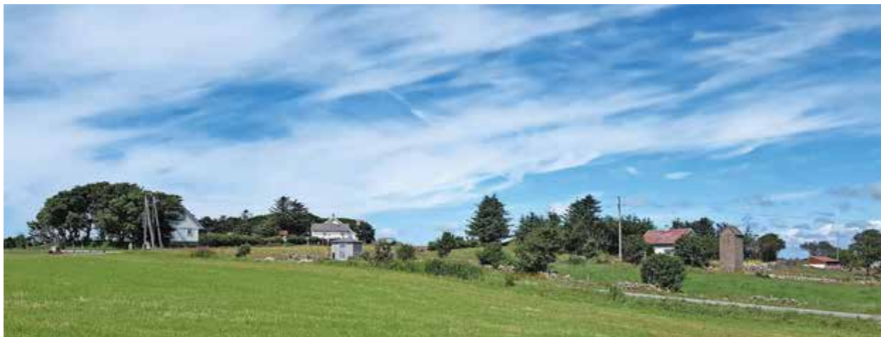
Tre generasjoner nettstasjoner på Reime. Disse viser utviklingen av Jæren Everk. Tårnkiosken er fra 1916. Denne ble erstattet med en mastetrafo som igjen blir erstattet med dagens kabelkiosk. Foto: Birger Hayland, Jæren Everk
