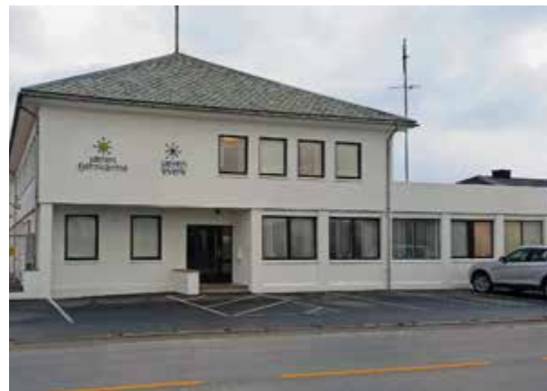
Kontorbygningen til Jæren Elektrisitetsverk ble bygd i 1958. Foto: Liv Margot Sviland, Jæren Everk.
