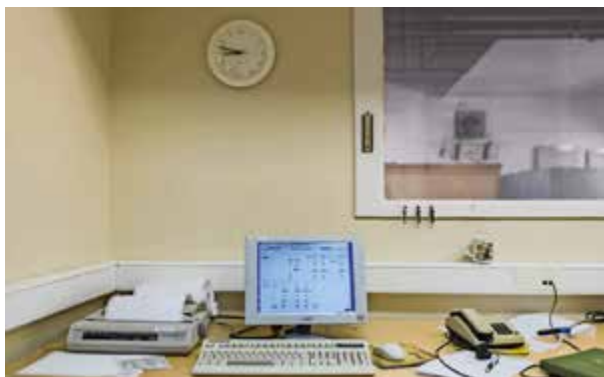
Kontrollrommet i Hetland transformatorstasjon. Foto: Tord Paulsen
