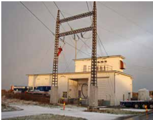
Arbeid ved Opstad trafostasjon på en regntung dag. Montørene klatrer likevel i høyspentmastene. Foto: Birger Høyland, Jæren E-verk.
