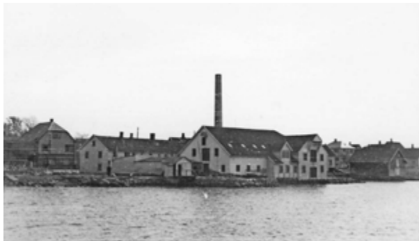
Fabrikkbygningen på Hana.
