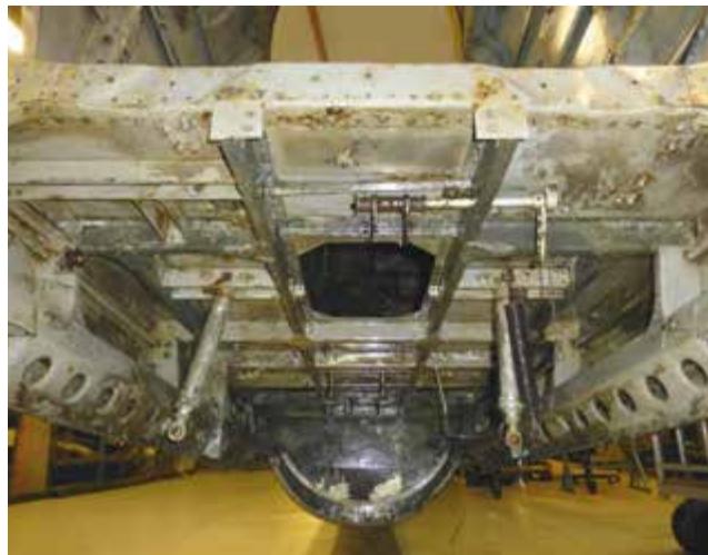
Bilde 13: det ferdig konserverte bomberommet i haleseksjonen. Foto: Eirik Aarebrot, Jærmuseet.
