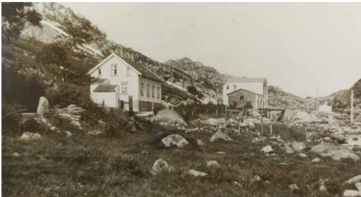
Hetland kraftstasjon slik den var fra 1915. Foto: Ukjent. Jærens Elektrisitetsverk.
