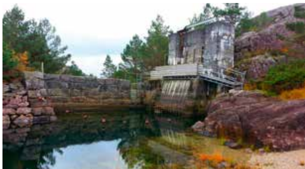
Innløpet til tunnelen i Holmavatnet . Konstruksjonen i bakgrunnen er lukeanordningen foran tunellåpningen. Foto: Liv Margot Sviland, Jæren Everk.
