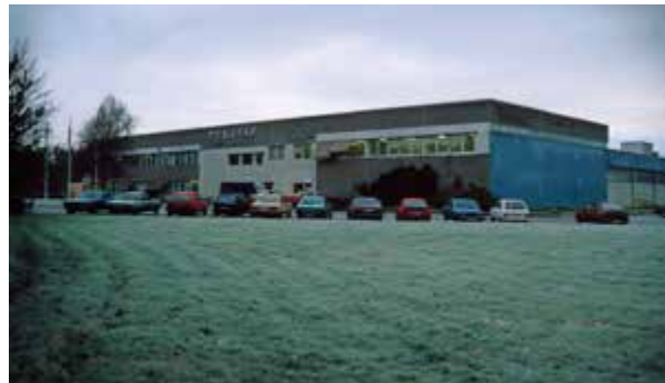
Fabrikklokalene på Orstad i Klepp.
