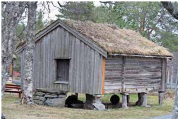
Truleg er dette den eldste stolpabuå på Romsdalsmuseet. Det var berre ei lita dør som ga det einaste lyset inn, elles var det ingen gluggar eller glas. Det galdt å halda så låg og jamn temperatur som råd. Foto: Hans Torgny Indrebø.
