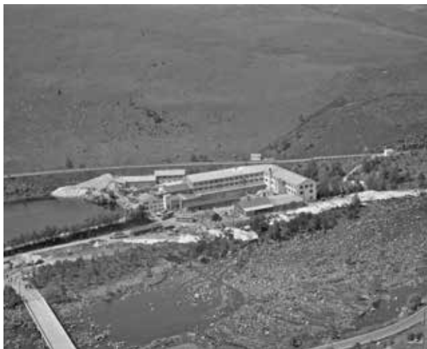
Figgjo Fajanse AS i 1954. Den største delen av fabrikkbygningene, i vinkel, er fortsatt en del av bygningsmassen i dag. Men mye av det som her er elv, er forlengst blitt byggegrunn og parkeringsplass. Rolf Frøyland kjørte arbeidsbuss fra Høyland i 1954 og på fotografiet er det flere busser. Foto: Widerøe Flyfoto, IKA Sandnes kommune
