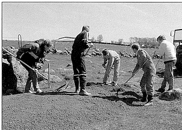
I løpet av 1995 var ungdomskoleelever og bønder fra Hå engasjerte til å bygge tursti i Hanabergsmarka. Stien ble laget ved å legge grus direkte på grasmarka.
