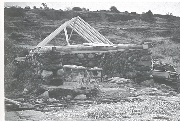
Restaurering av naust i Tungevågen. * Foto: Helge Schjelderup.
