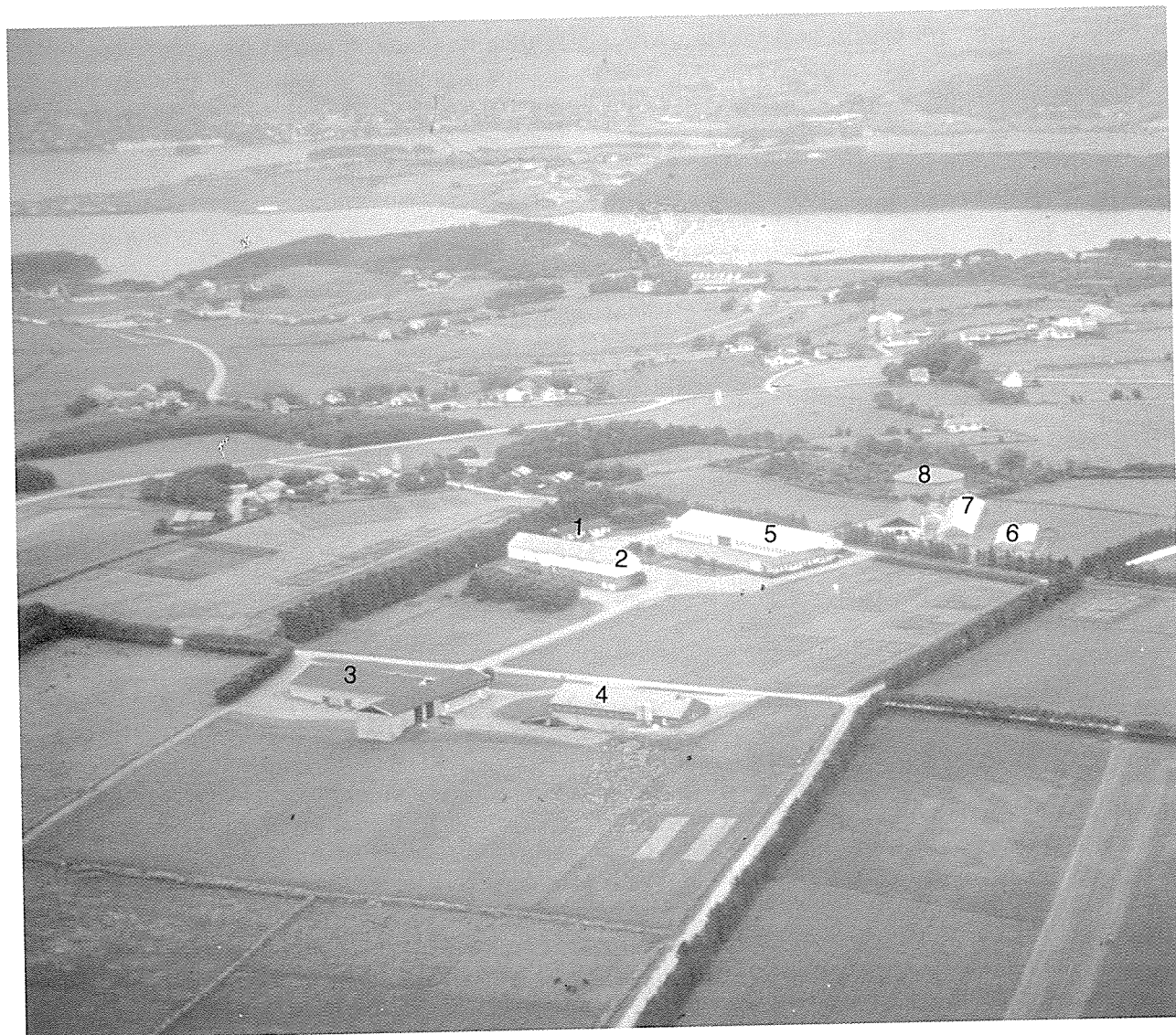
Særheim forskingsstasjon 1990. I drift fra 1965.
