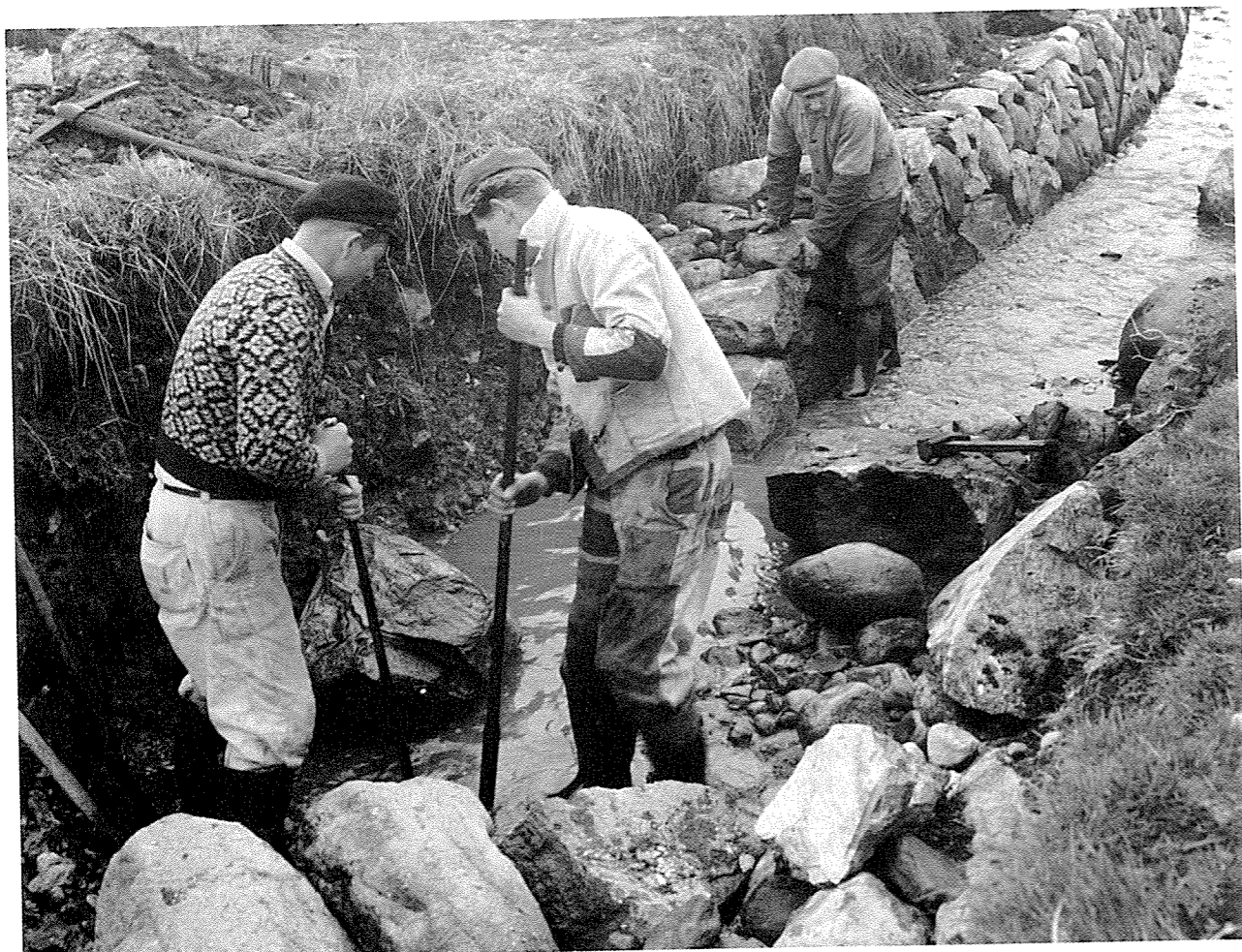
Senking og steinsetjing av Reiestadbekken 1953. Frå v.: Trygve Ueland, Torstein A. Varhaug. Bak: Nils Tjemstrand Foto: Forfattaren
