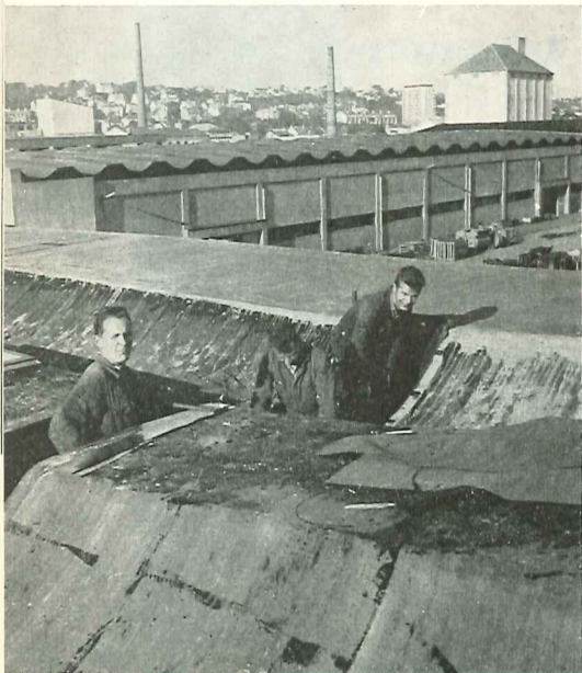
Blikkenslagerne i arbeid på taket. Fra venstre: Åge Olsen, Kristian Trælnes og Svein Øverland.
