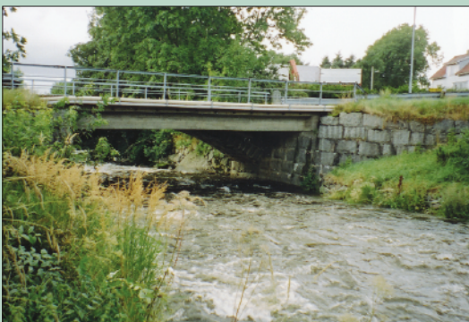
Undheim bru etter utvidinga frå 2,5 meter til 6 meter i 1952. Den gamle steinkvelven frå 1901 kan vi skimta under brua. Det første meieriet på Undheim låg der treklynga i framgrunnen nå står. Foto: H.T. Indrebø.
