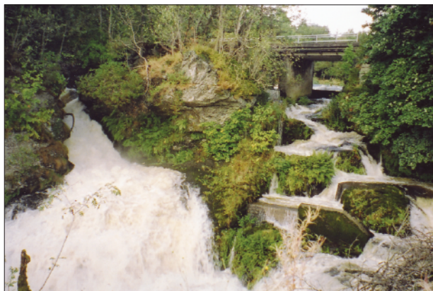
Fotlandsfossen brusar heftig i haustflaumen i august-september 2004. Det er rikeleg med vatn i laksetrappa bygt i 1952. I bakgrunnen er den nye Fotlandsbrua. Brukaret til den gamle ligg bak bergknausen midt i biletet.
