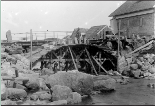
Undheim bru er her under bygging i 1901. Det var nok spanande å sjå korleis det ville gå når stillaset i tre vart fjerna. Bak stillaset kan vi sjå den gamle brua omtalt allereie i 1837. Huset til høgre er Undheim meieri bygt bare eit par år før etter teikningar av meierimeister J. Grude. Foto: Jens L.A. Bassøe * Statsarkivet i Stavanger.
