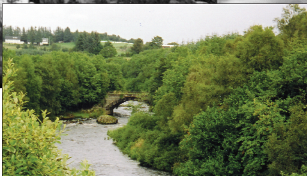
Fosse bru sett frå den nye brua lenger nede i elva. Legg merke med korleis det har grodd til med tre og buskar langs åa. Foto: H.T. Indrebø
