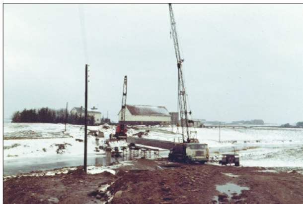
På 1960-talet blei den gamle hengebrua på Nesheim riven og Br. Risa la kloakken frå Nærbø til sjøen i denne traudragaren. På toppen blei det montert ei ny gangbru, som framleis er i bruk. Foto utlånt av Br. Risa.
