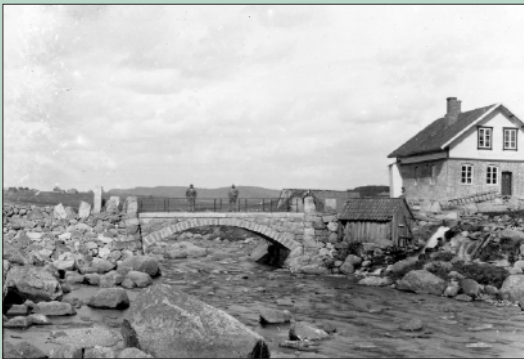
Undheim bru står ferdig, og den gamle brua er fjerna og materiala selde. Det er Årestadgarden vi ser i bakgrunnen. Det vesle huset i åkanten er ei av dei mange bekkakvernane som låg til åa på Undheim. Foto: Jens L.A. Bassøe. * Statsarkivet i Stavanger.
