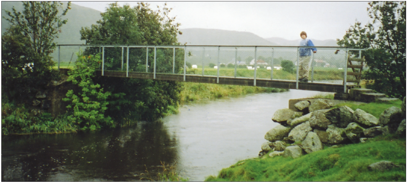
Roger Risa er på veg over "Planken" – ein regnvørsdag i september 2004. Det var ein gong ei bru over åa her som fekk avløyising av denne "planken" - ei gangbru - i betong mellom Taksdal og Litla Undheim. Foto: H.T. Indrebø.
