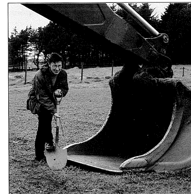
Målfrid Snørteland tek fyrste spadetak til 2. byggetrinn på Kvia i slutten av november 1999.
