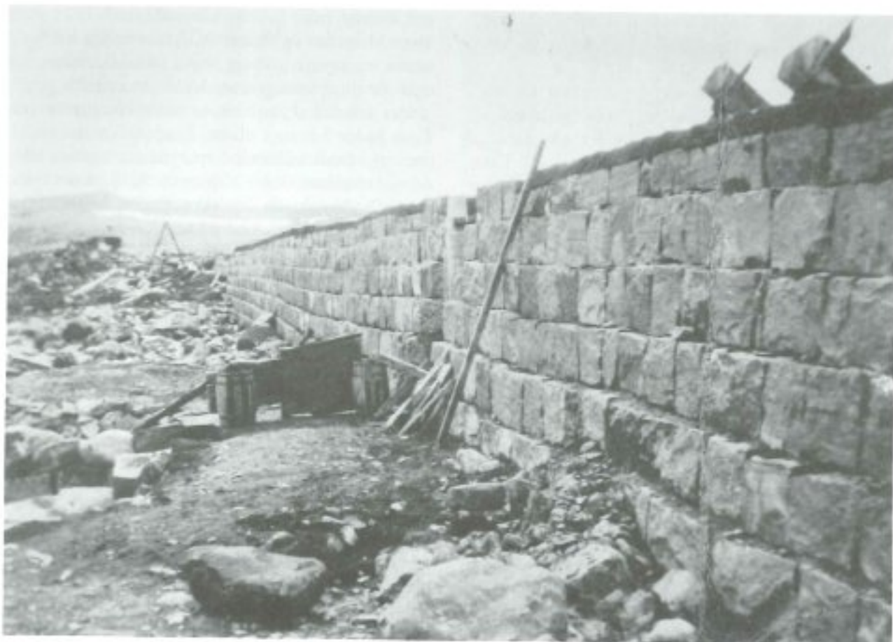
Dette er ikkje den kinesiske muren, men demning ved Storamø. Sjøtvsagt er både steinbukk og sluskabærer på plass. * Time kulturkontor
