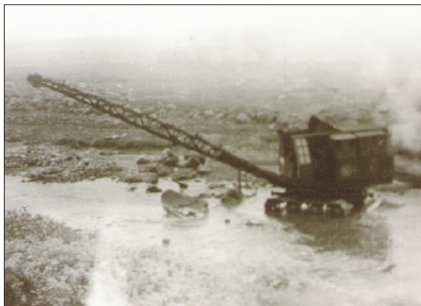
Håelva esar fort opp ved nedbør og går raskt attende ved opphaldsvær. For å minka på skadane ved flaum, har elva vorten retta på og botnen senka fleire gonger mange stader. Gustav Mæland er her i ferd med senkingsarbeid i Annabakkstraumen på Søyland for Brødrene Risa – Risakarane – rett etter krigen. Foto utlånt av Risa AS.
