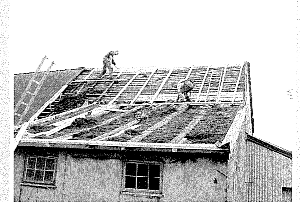
Frå Audamotland: Ståle Skretting og medhjelpar i arbeid på taket.
