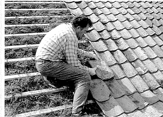
Frå Audamotland. Lars Ødemotland legg på plass takpannene på heimahuset. Under er taket isolert på "gamlemåten" med lyng.
