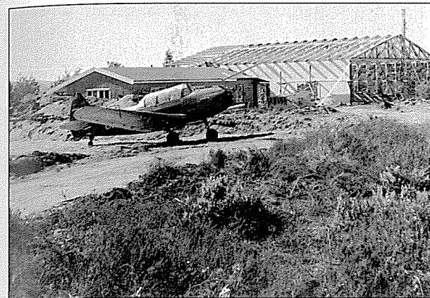
Bygging av hangar og restaurant på Geiteryggen vinteren 1957/58. Foto: R. Kjetilson/Flyhistorisk Museum
