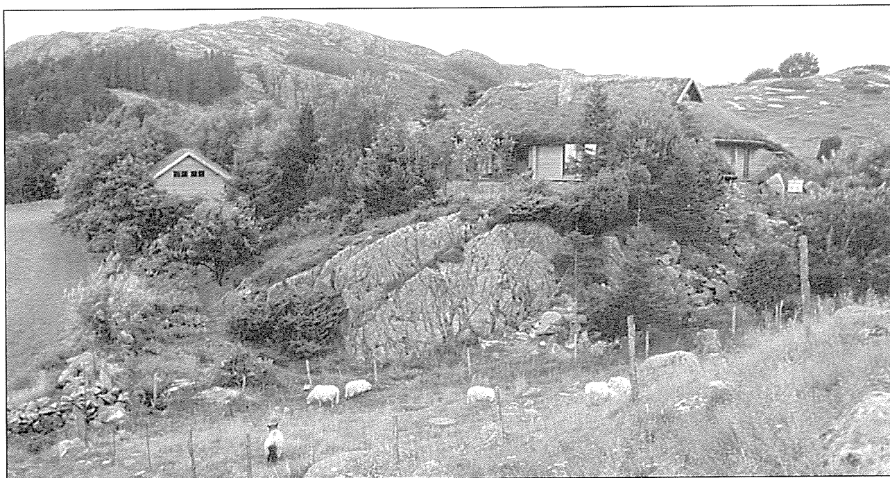
Forfatterens økologiske hus på Fuglestad i Hå, bygget i 1976.
