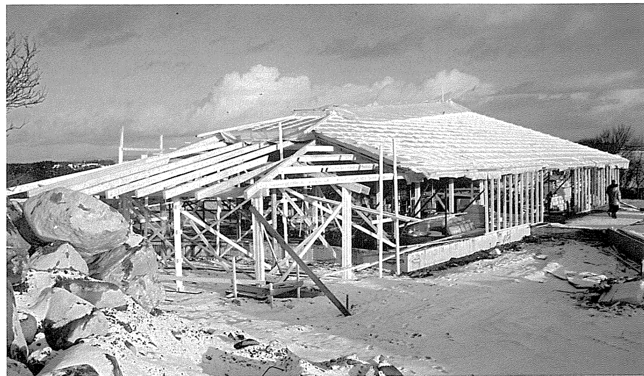
Nybygget under oppføring i desember 1993.
