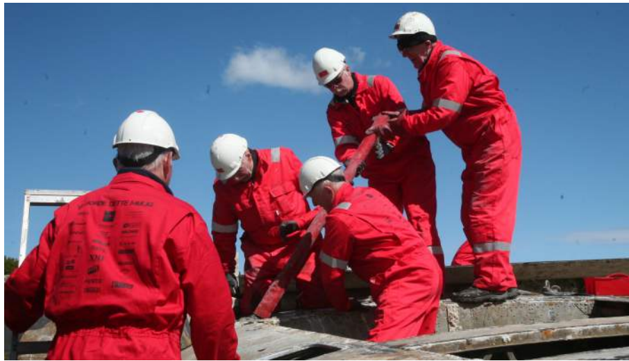
Over . Fra demontering av vingene. Vingene er er festet med fire store bolter, se under som var i forbausende god stand etter 70 under vann,
